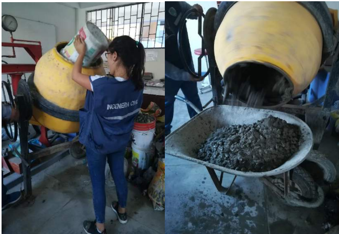
Foto N° 14. Se observa la mezcla ya realizada
