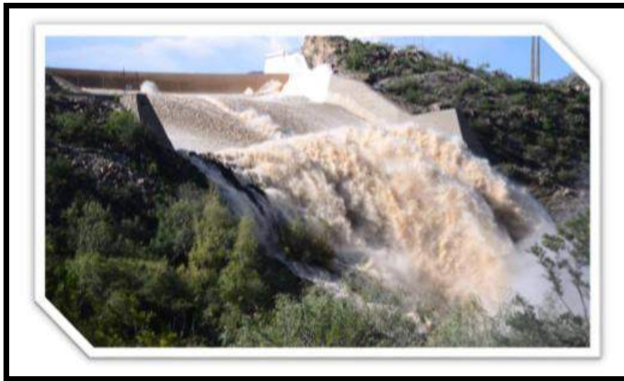
Figura 4: Rompimiento de una presa por mala operación.
