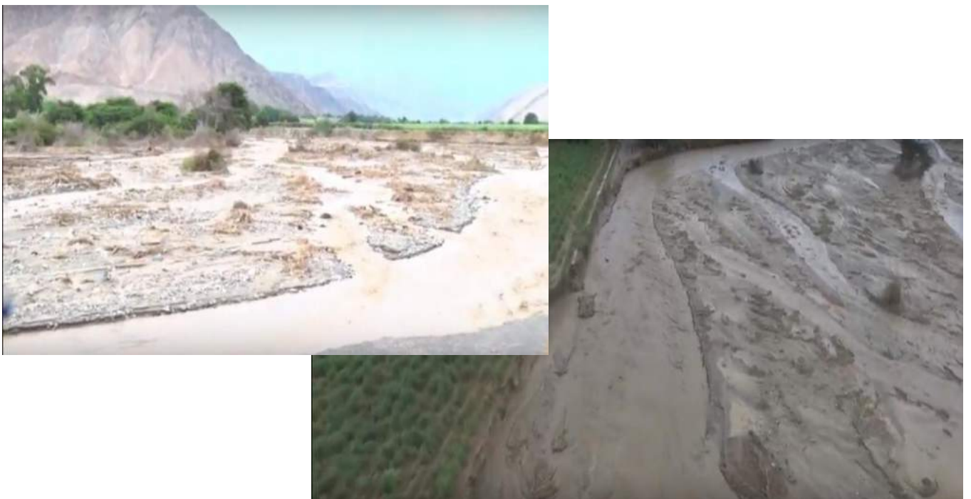
Figura 23: En esta imagen se muestra el aumento del caudal y perjudicando la carretera de Huanchay
