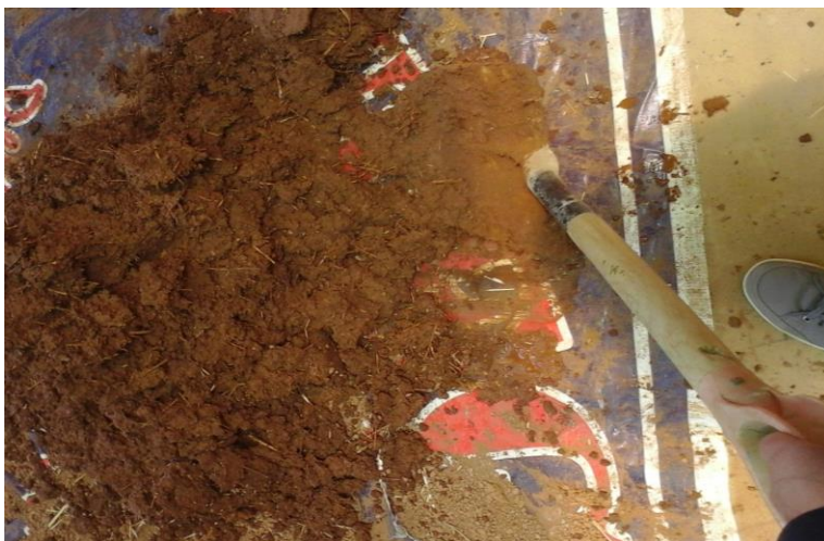
Fotografía 16. Mezclado de tierra con la goma de tuna.
