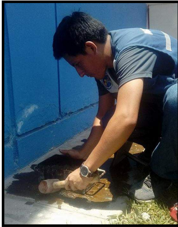
FOTO N° 20. Evitando Vacíos con el Martillo de Goma.
