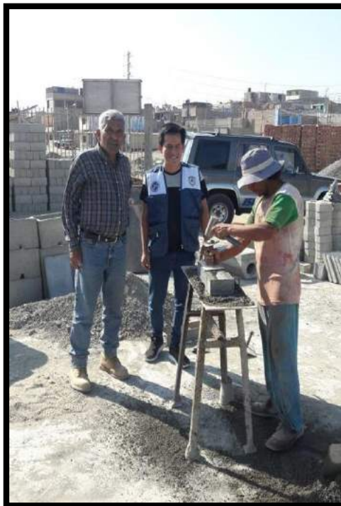
FOTO N° 31. Supervisión en el Compactado de los Ladrillos Patrón
