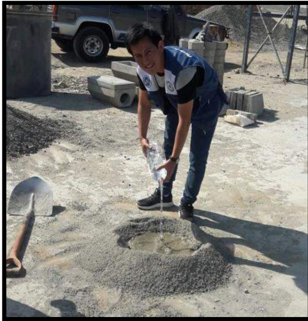
FOTO N° 30. Mezcla para Elaboración de Ladrillos Patrón
