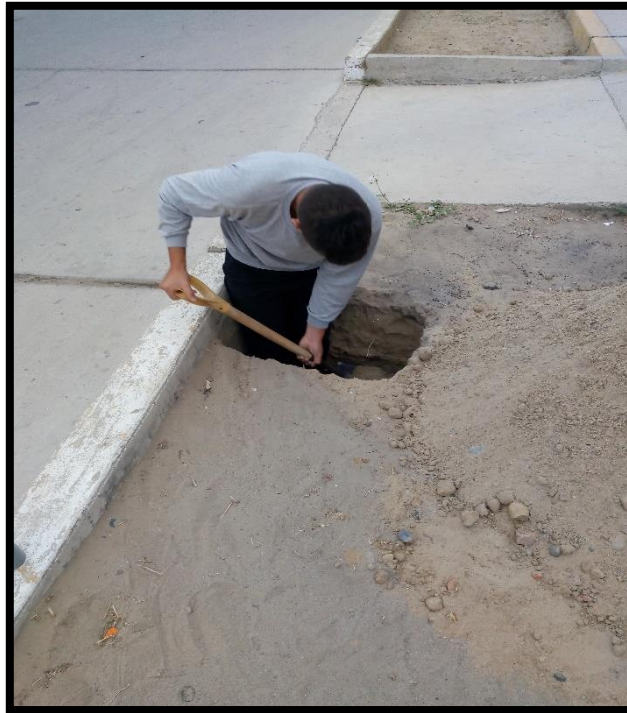
Figura 29: Tratando de llegar a la sección transversal del pavimento.
