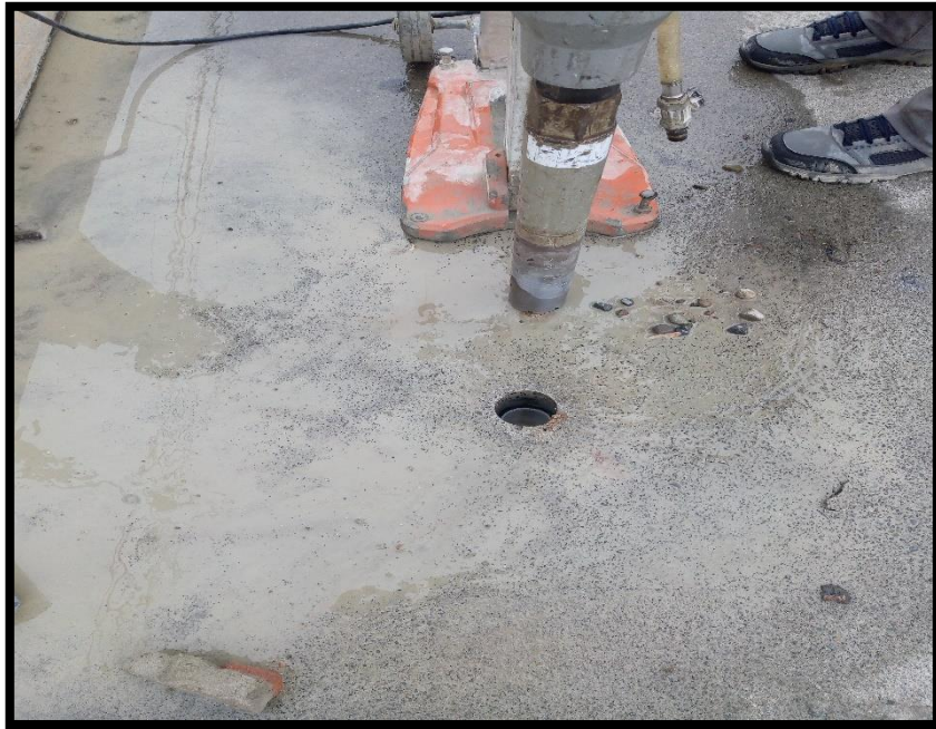
Figura 39: Extracción de la primera diamantina.
