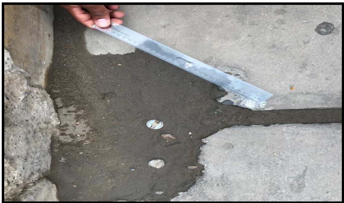
Figura 24: Tomando medidas, al llenado de las juntas falladas.
