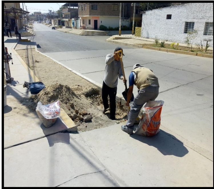
Figura 31: Muestreando a nivel de sub base del pavimento.
