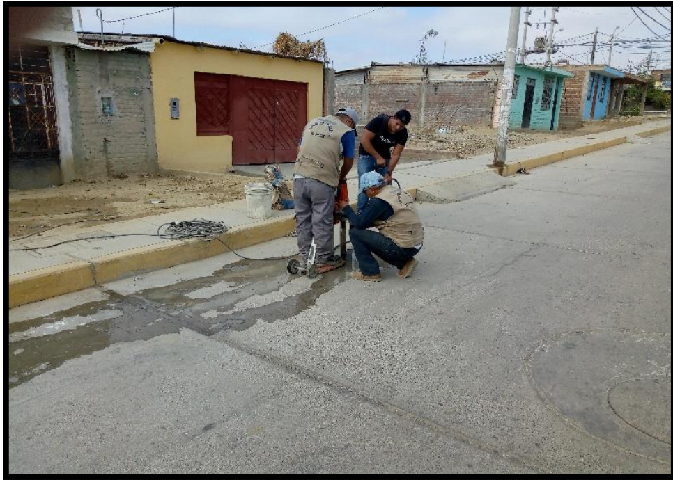
Figura 45: Iniciando la tercera perforación.
