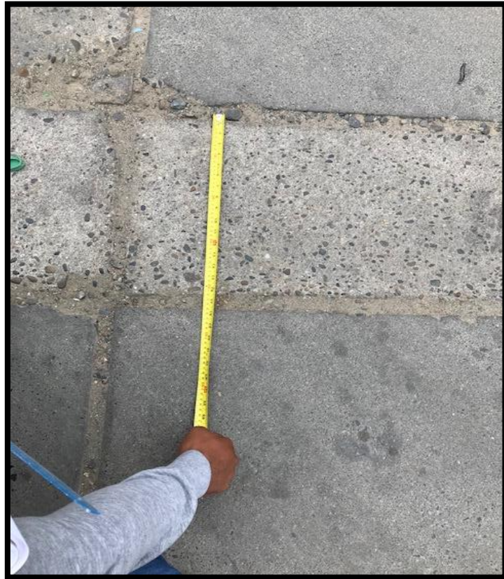
Figura 19: Midiendo la separación de las vías.
