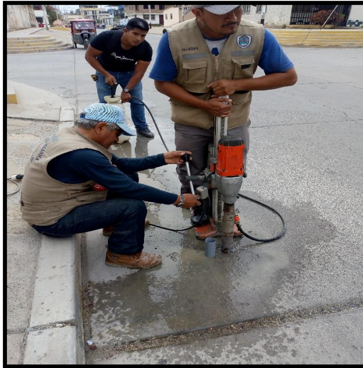
Figura 43: Terminando la extracción de diamantina.
