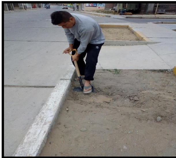
Figura 28: Iniciando la excavación de la primera calicata.
