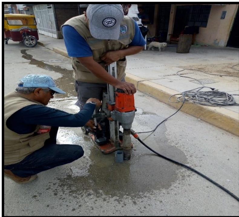
Figura 46: Llegando la perforación hasta el afirmado.
