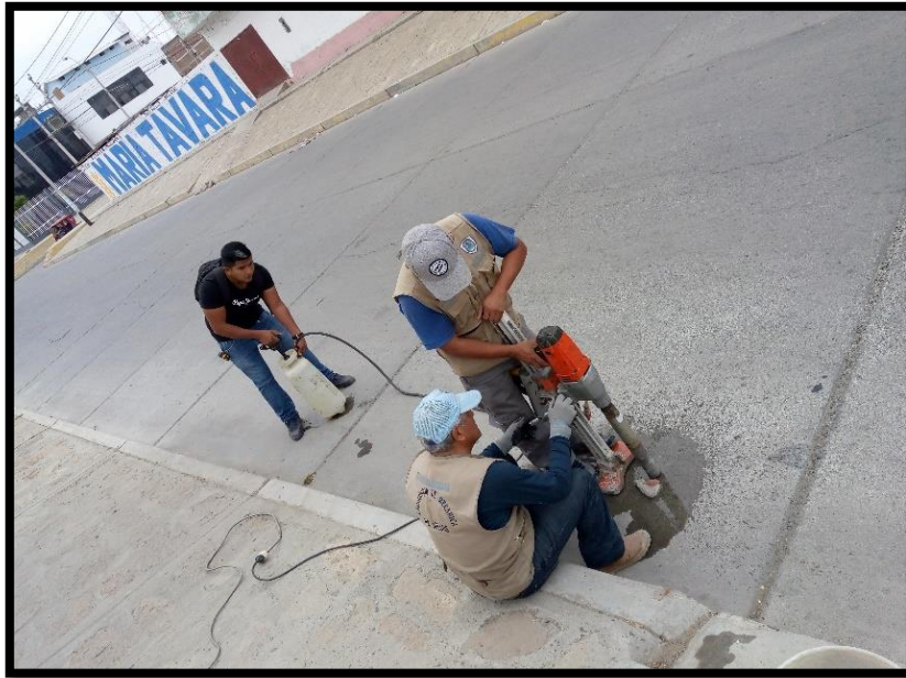
Figura 37: Iniciando la perforación del pavimento.
