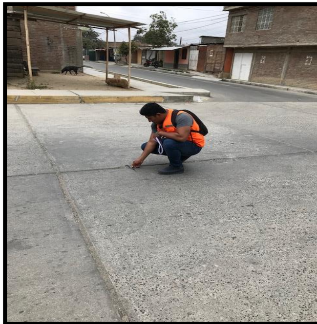
Figura 26: Midiendo la junta de separación de las vías.
