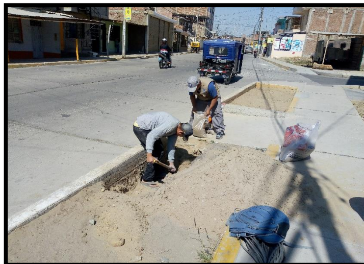
Figura 30: Muestreando a nivel de base del pavimento
