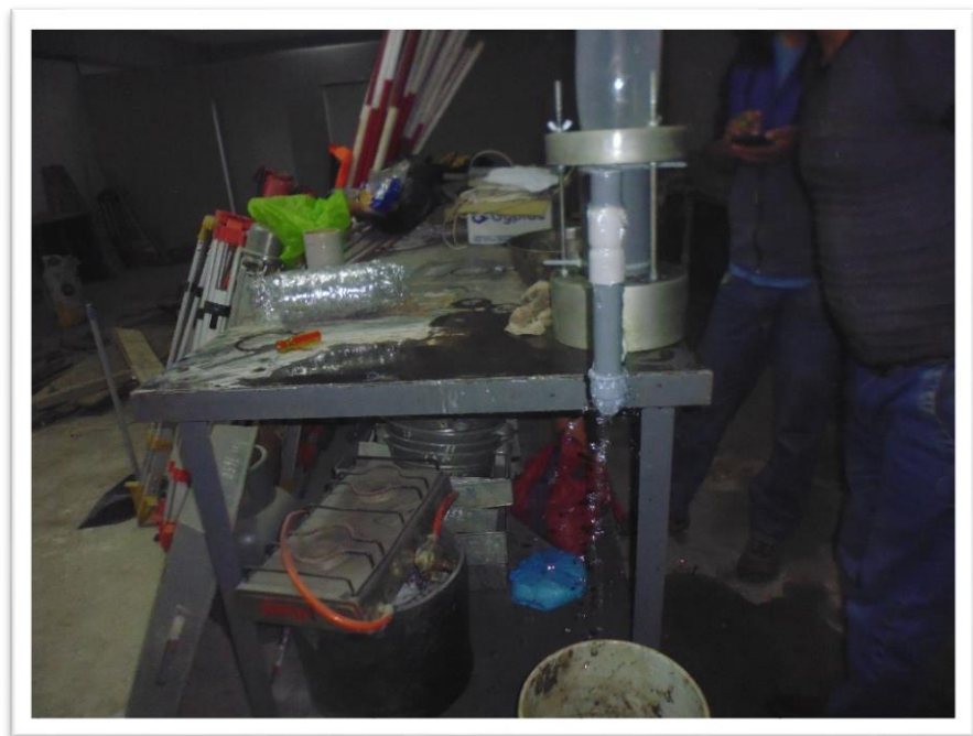
Imagen. 12 Se observa el drenaje del concreto permeable.
