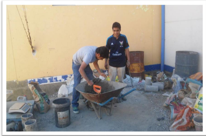
Imagen. 05 Se observa el proceso para la consistencia del concreto.
