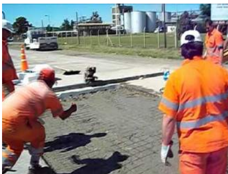
Figura 8 reemplazo de losas
