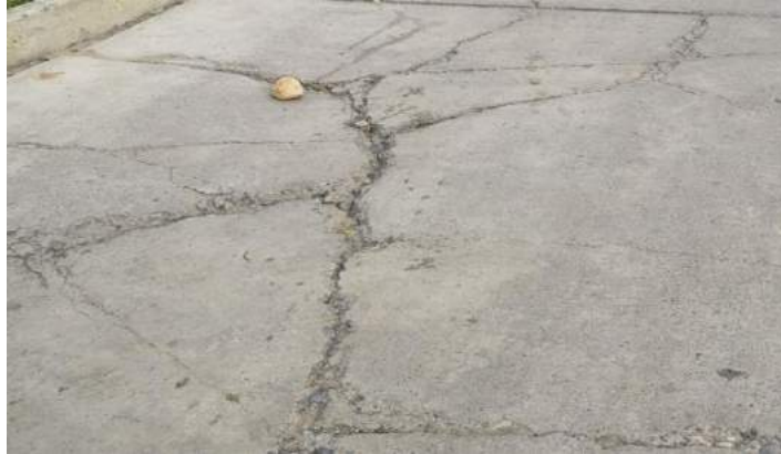
Figura 3 losa sub dividida
