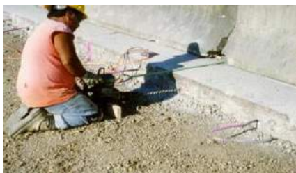
Figura 7 Reparación del espesor total de la losa
