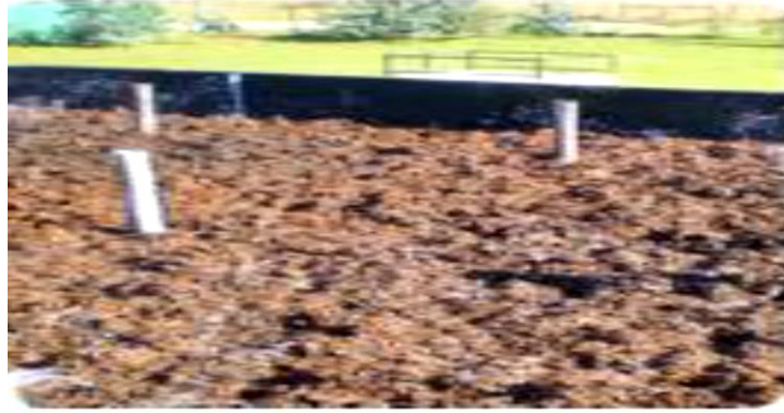
Figura 8. Aplicación de las tuberías para la aeroción (Tapia, L., & Barañao, P: 2004, P.111)
