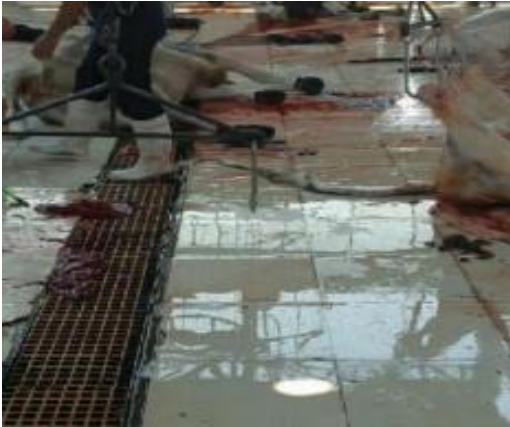
Canaleta interna en la zona de faenado
