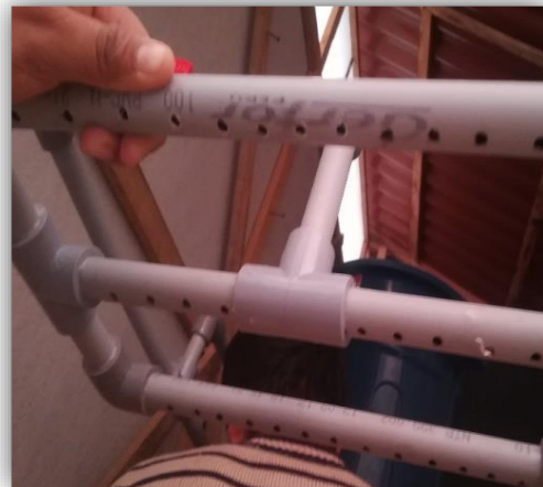
Perforacion de tuberias para el sistema de alimentacion al biofiltro de lombrices
