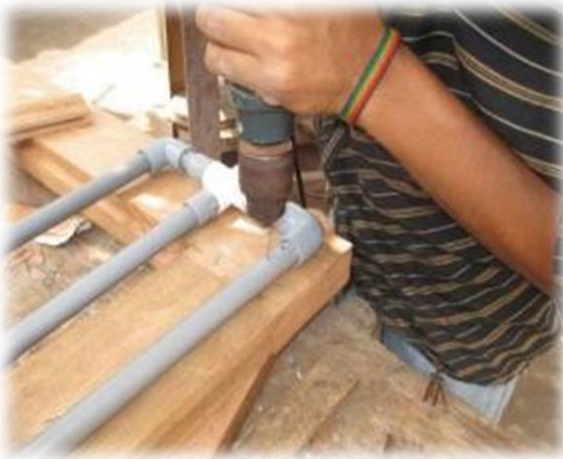
Perforacion de tuberias para el sistema de alimentacion al biofiltro de lombrices
