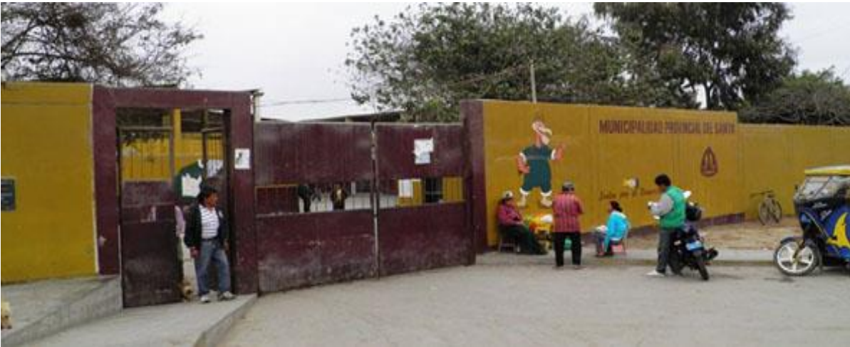
Infraestructura, camal municipal de chimbote
