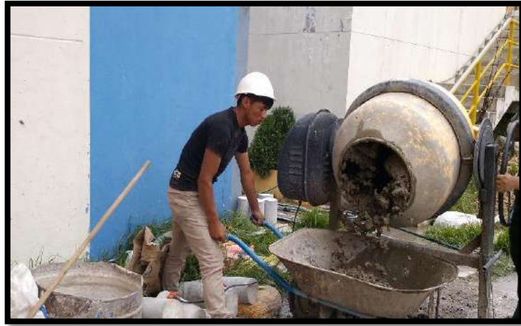
28: realizando el sacado de la mezcla del trompito Fuente: Fuente: Elaboración propio.
