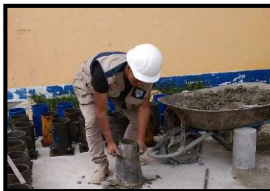
Figura 22: Retirando cuidadosamente el molde
