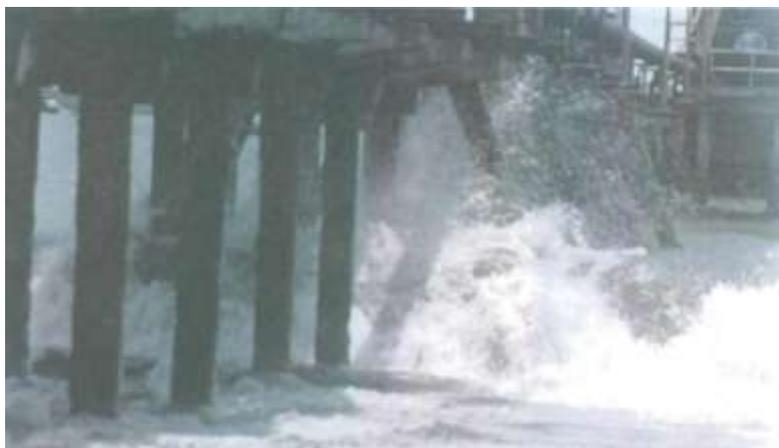
Figura N.º 22: Efecto de la presencia de pilotes de un muelle, constituyen un obstáculo a la energía de las olas.
