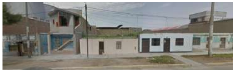
Figura N°19. Estado de conservación de las Viviendas Fuente: Elaboración propia
