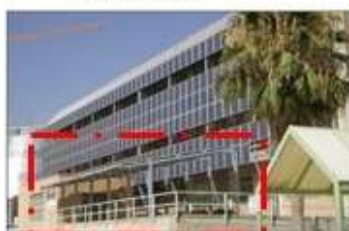
Foto: "Estructura de la pérgola y fachada"
