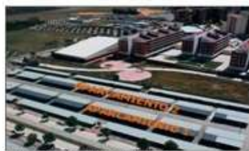
Foto: "Generador Aparcamiento 1 y 2"
