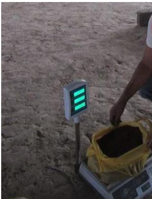
Figura 17. Pesando el suelo para elaborar El adobe.
