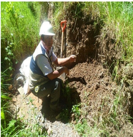
Figura 03. Limpiando material orgánico.
