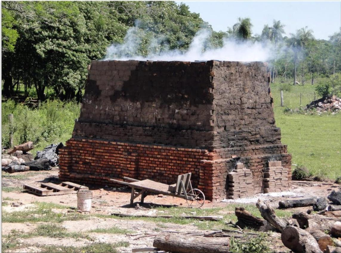
Figura 7: Horno Intermitente con suelo y muros laterales, típico de México (Jiménez y Salazar, 2005)
