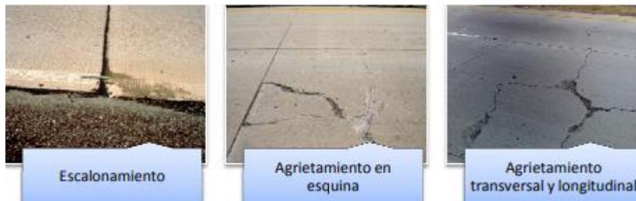
FIG.5: Escalonamiento, agrietamiento en esquina, agrietamiento transversal y longitudinal
