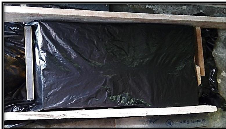
**Figura 27:** Aislamiento con manta plástica
