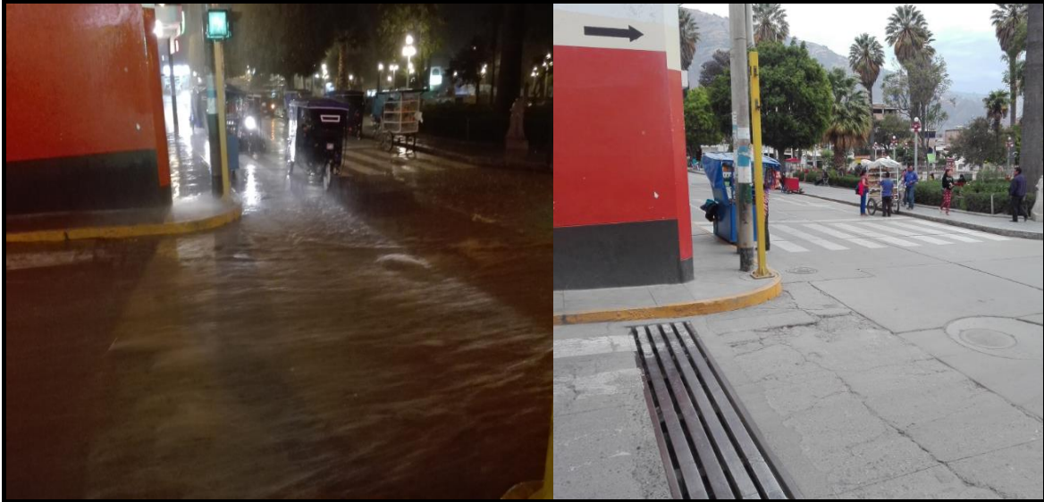
Foto 1-2: Caudal de aguas de lluvia que colapsa sumidero, intersección Jr. San Martín y Av. Daniel Villar (esquina de la Plaza de Armas)
