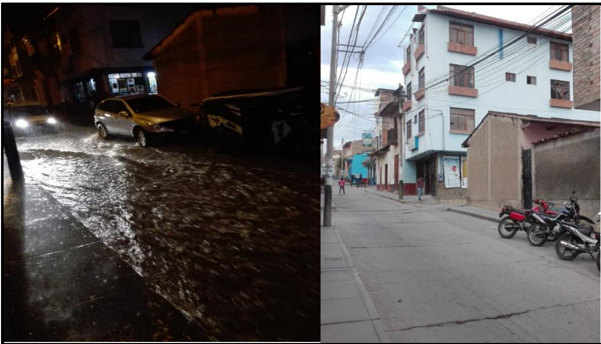
Foto 3-4: Caudal de aguas de lluvia discurren por toda la calzada, Jr. San Martín
