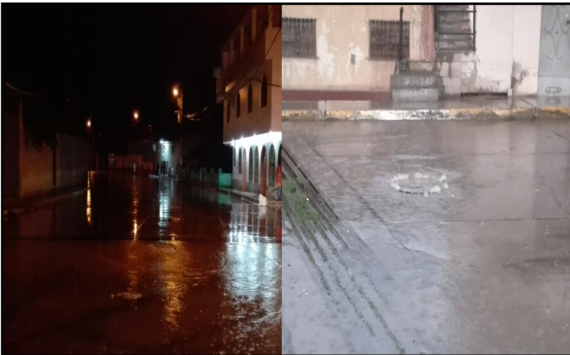
Foto 7-8: Colapso de aguas de lluvia por buzones del alcantarillado sanitario, intersección de Av. Daniel Villar y Carretera central.
