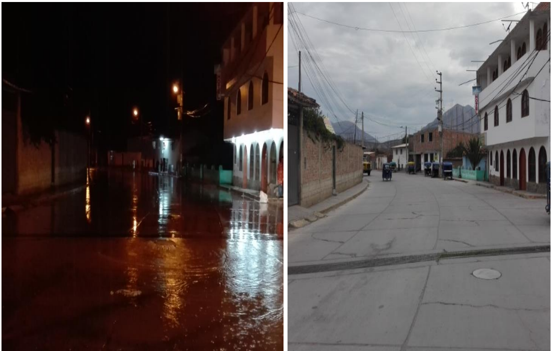
Figura 17. Desborde de las aguas de lluvia por el alcantarillado sanitario Nota: foto tomada en Marzo del (2018) Intersección Av. Daniel Villar y Carretera central
