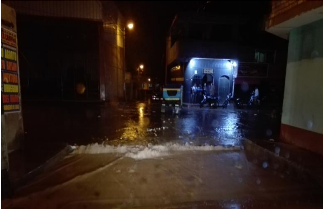
Figura 19. Alcantarilla (sumidero) colapsado
