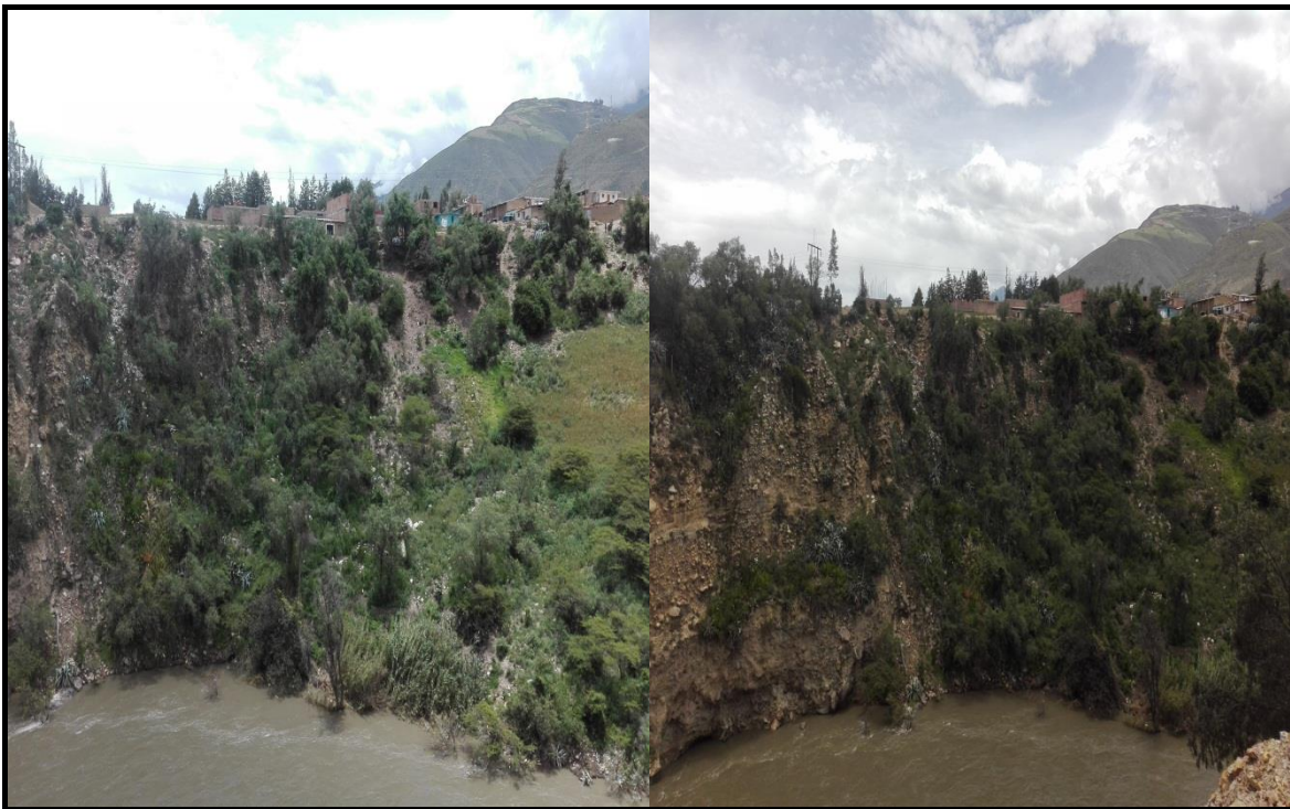
Foto 19-20: Disposición final de las aguas de lluvia, puntos de vertimiento es el Rio Santa. Nota: Tomado en Enero del 2019.
