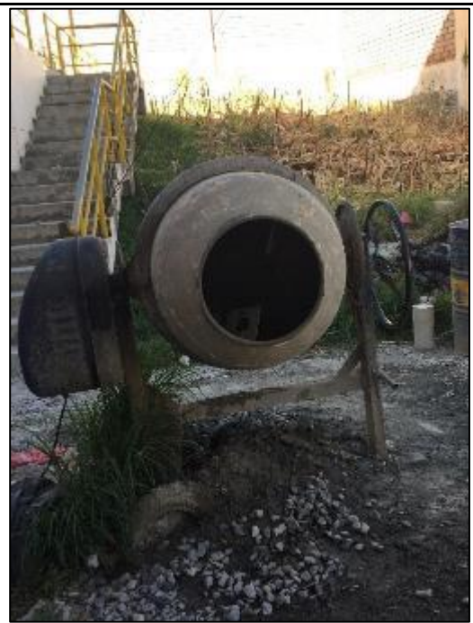
Foto N°39: Se observan la mezcladora que se utilizó para el mezclado de los nuestros materiales.
