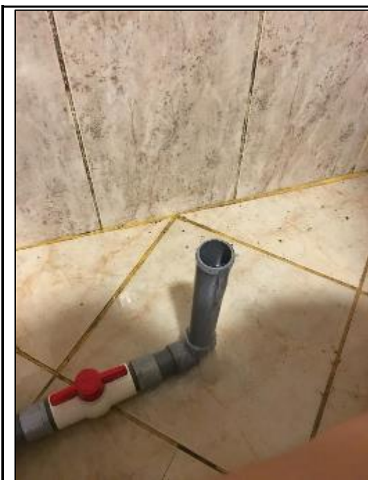
Foto N°54: Permeabilidad: Se observa que una vez abierta la válvula empieza a descargar, y parara una vez que llegue al nivel en el que se encuentra la parte superior de la probeta, Este nivel se considera como H2.
