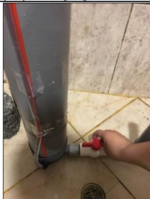
Foto N°53: Permeabilidad: Una vez ya cargada el agua hasta el nivel de 30cm, se procedió a abrir la válvula.
