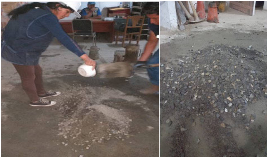
Fotografía N° 10: Mezclado manual de los agregados
