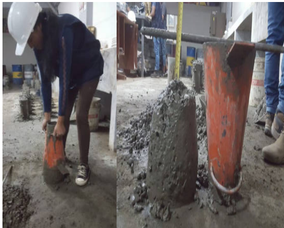
Figura N° 17: Medición del asentamiento
