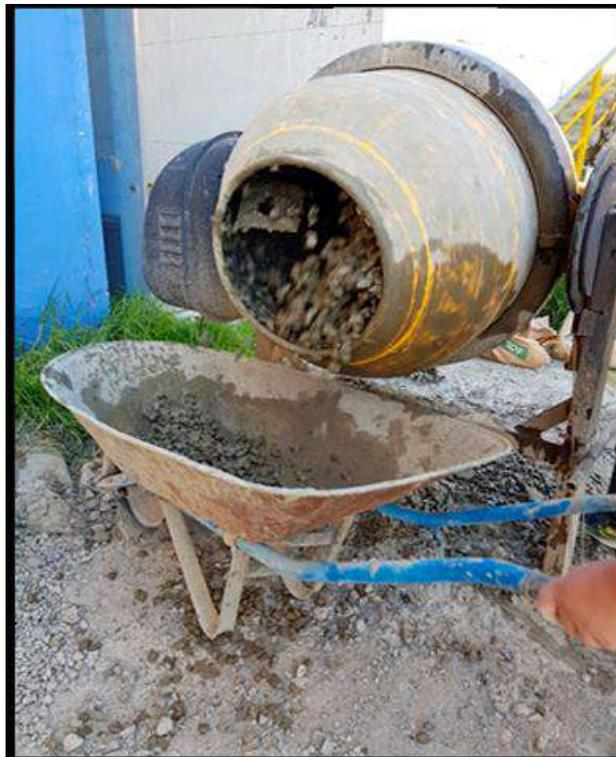
**FOTO N° 15:** Preparación de mezcla de concreto.
