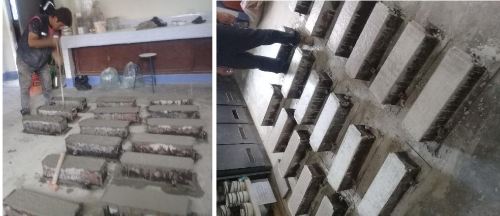
Figura 16. Elaboración de las vigas de concreto 1.5% y 2.5% con alambre n° 16
