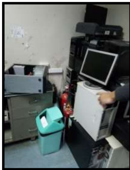
EXTINGUIDORES DE INCENDIO MAL UBICADOS
