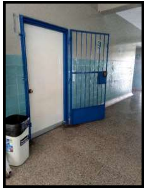
PUERTA DE INGRESO AL CENTRO DE DATOS
