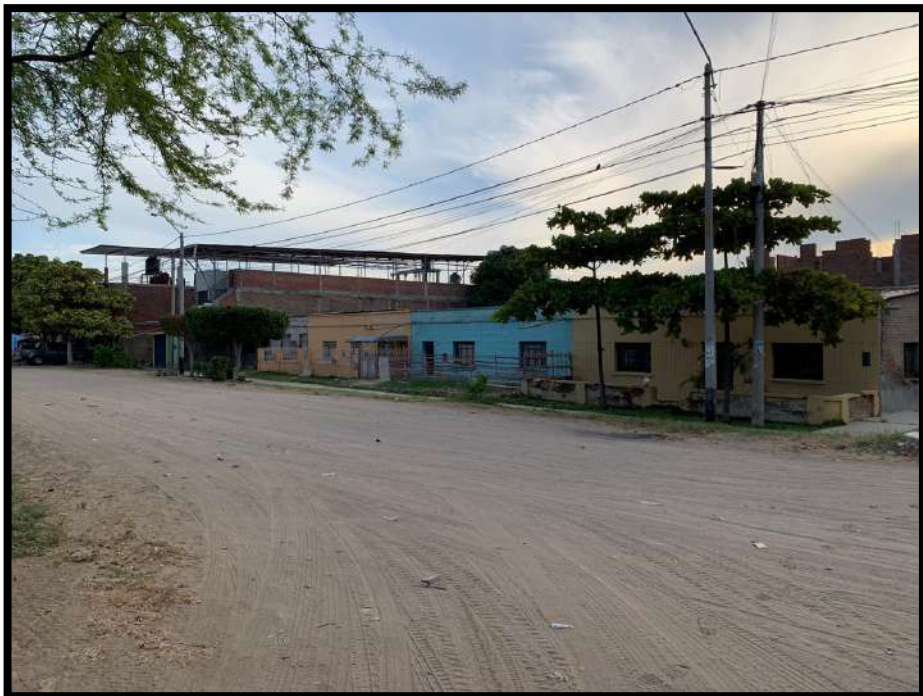
Figura 52: Viviendas aledañas al terreno propuesto.
