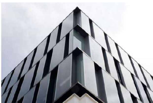
Figura N° 75: Estructura de Fachada - Corriente Alternada
