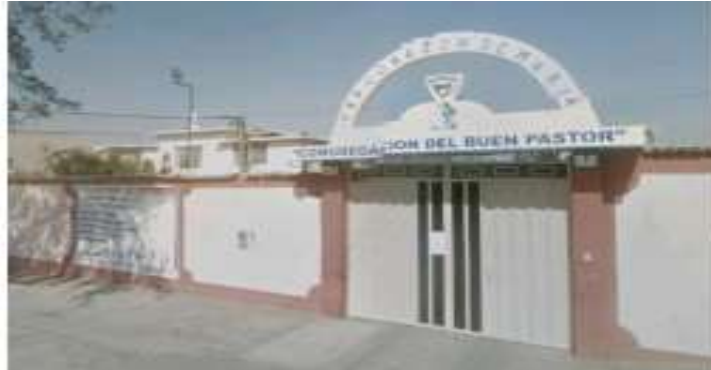
Figura 80: Fachada principal del Albergue Residencia Transitoria Fuente: Google
