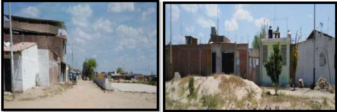
Figura 30: Vista de viviendas aledañas y su sistema constructivo Fuente: Elaboración propia 2019
