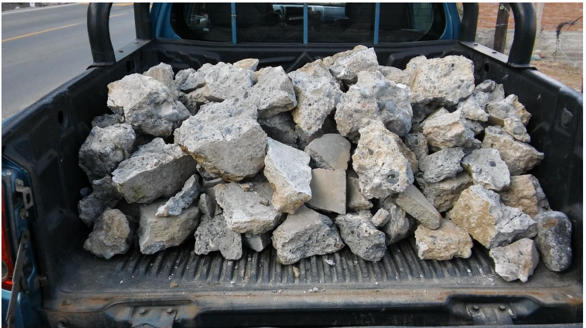
En esta imagen vemos el concreto reciclado en tamaños menores de 9" listo para ser trasladado.
