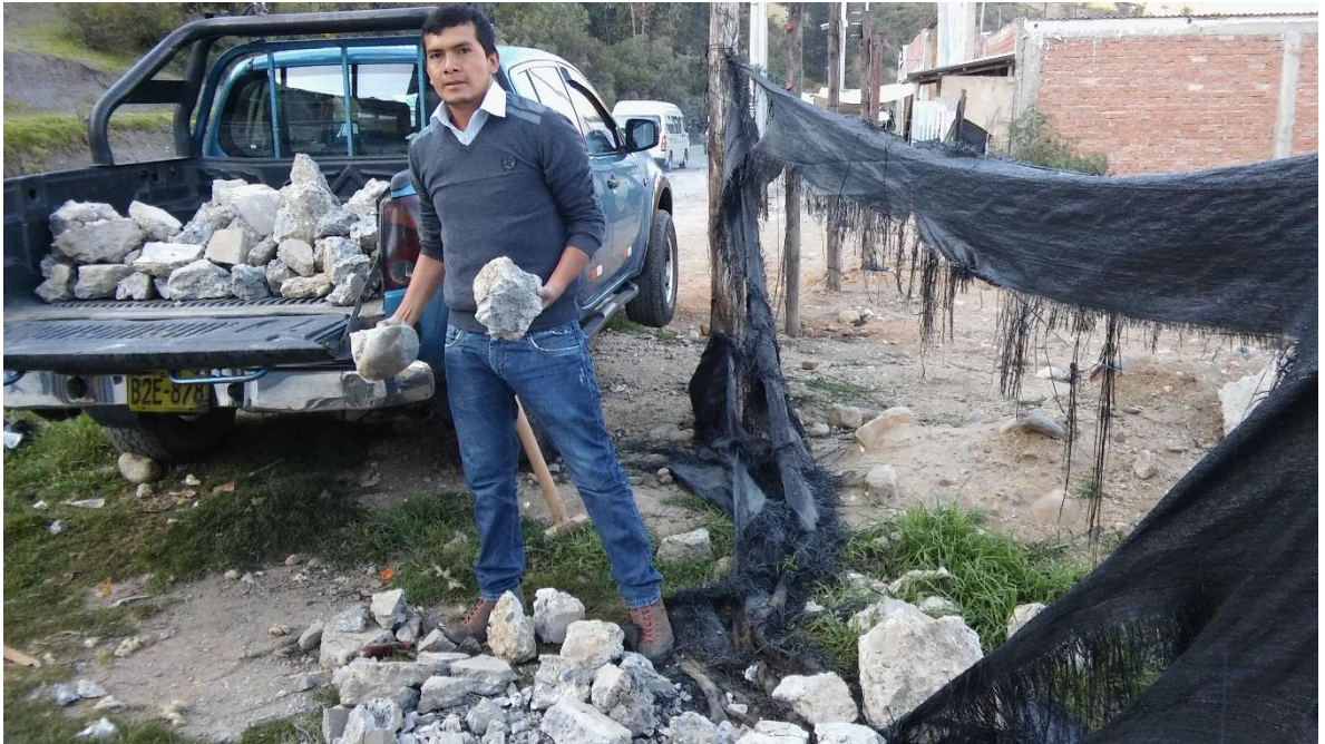
En esta imagen se muestra cargando el concreto reciclado para ser transportado a la planta.
