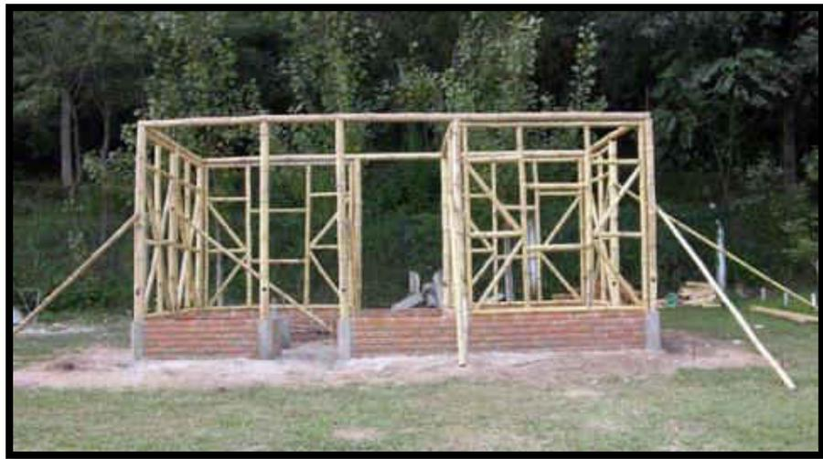
*Figura 73. Muros estructurales*
