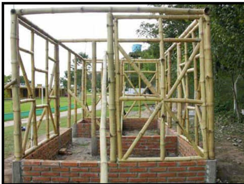
*Figura 74. Muros estructurales*
