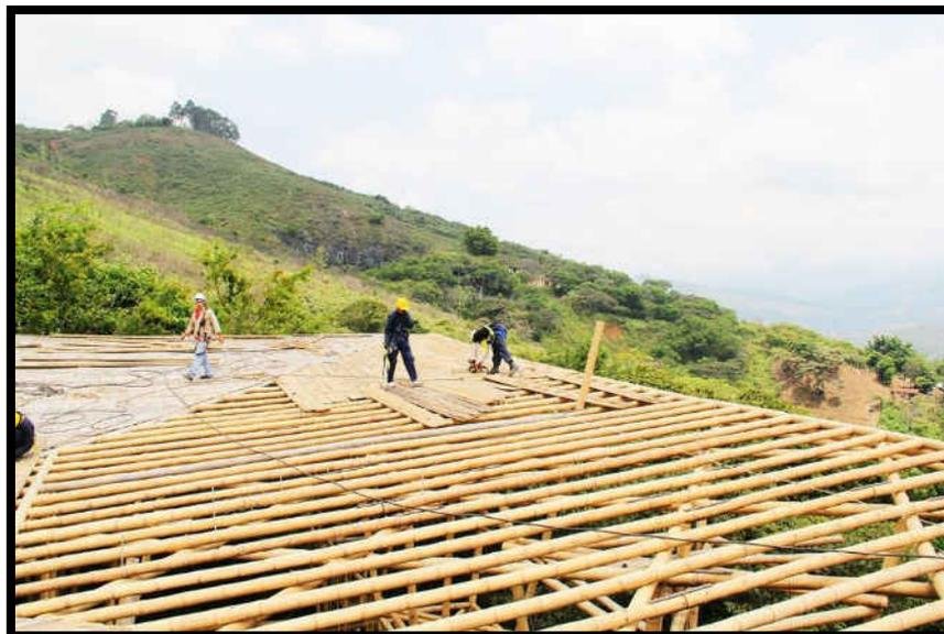
*Figura 90. Cubierta – entramado - bambú.*
