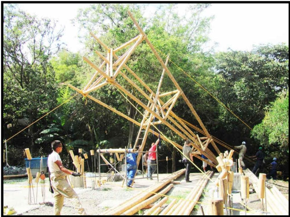
*Figura 87. Columnas de bambú*
