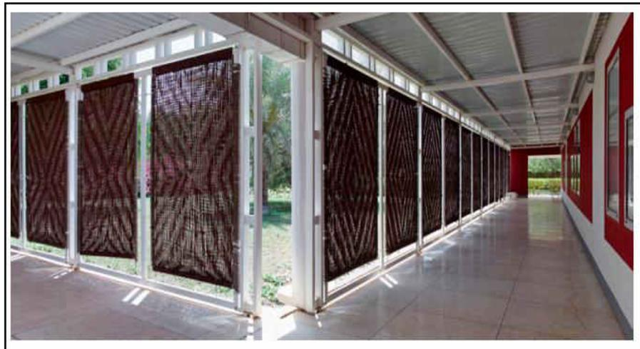
*Figura 15. Bambú en los muros del corredor interno - Centro de Cardiología Salam
