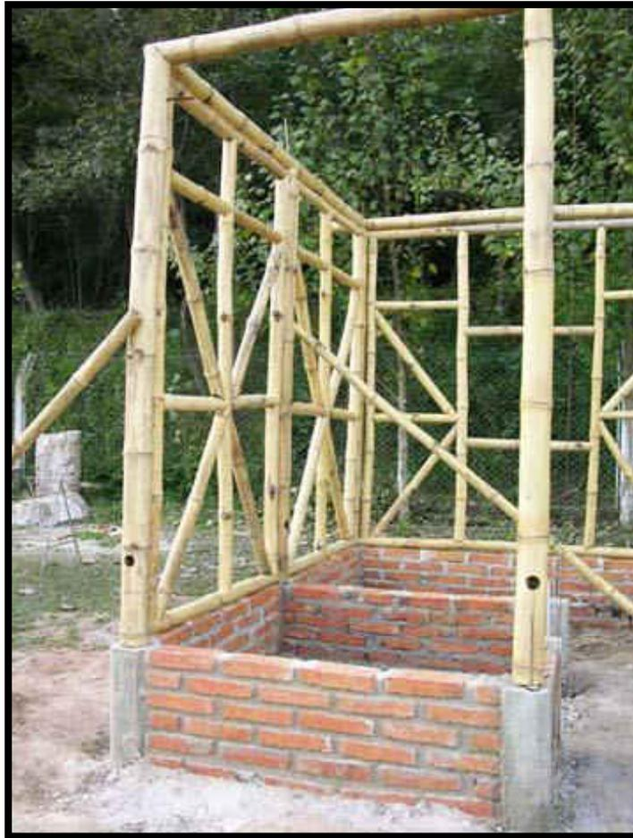
*Figura 85. Anclaje de bambú y cemento.
