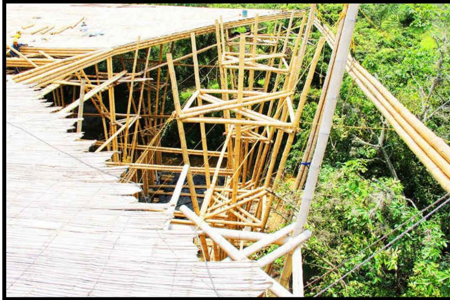
*Figura 89. Cubierta – tendido de esterilla.*
