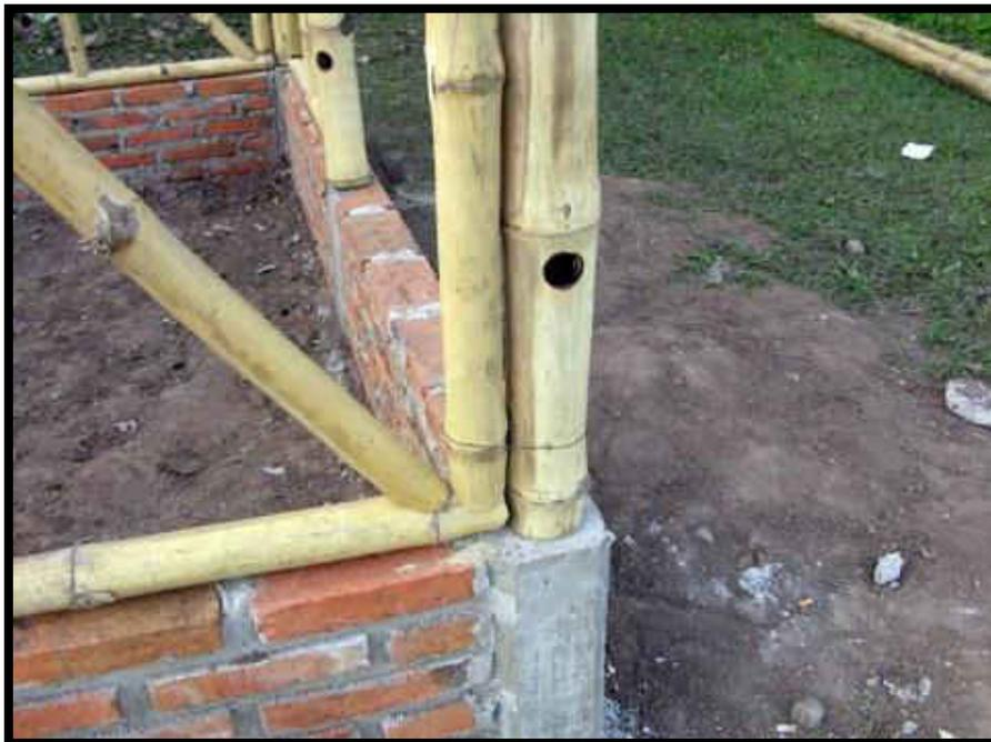
*Figura 84. Anclaje de bambú y cemento.*
