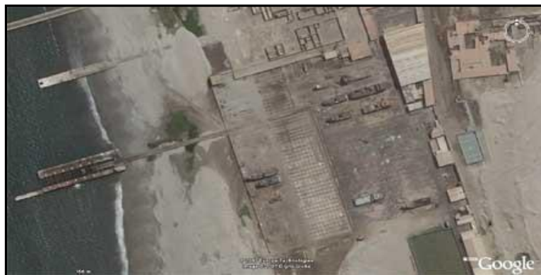
Figura N°6 – Fotografía Satelital Sima S.A. Chimbote
