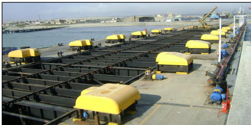
Figura N°12 – Plataforma Syncrolift Sima S.A. Chimbote
