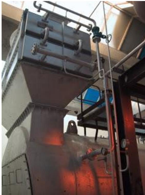
**Figura 8:** Precalentador (Economizador) instalado en la chimenea
