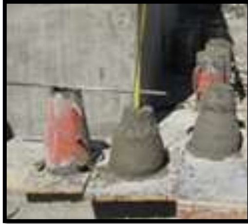
Figura N° 14: Prueba de Slump
