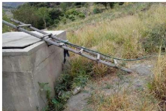
Esta poza de captación existente será un tanque de almacenamiento cuando se construya la nueva poza de captación, debido a que su volumen de 4.50 m<sup>3</sup> supera el volumen calculado según la dotación del C.P. Sacaycacha.
