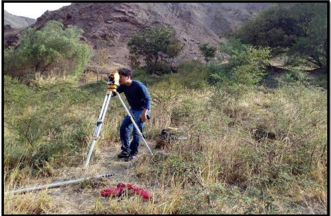
**Figura N°36.** Levantamiento topográfico de la zona del biofiltro con teodolito electrónico.
