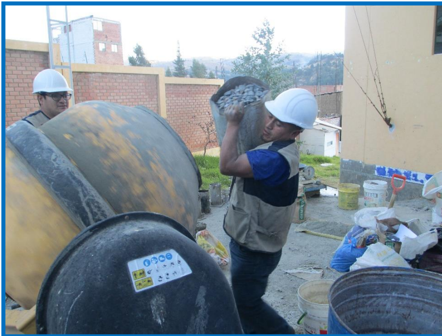
Figura 64: Preparación de la mezcla de concreto
