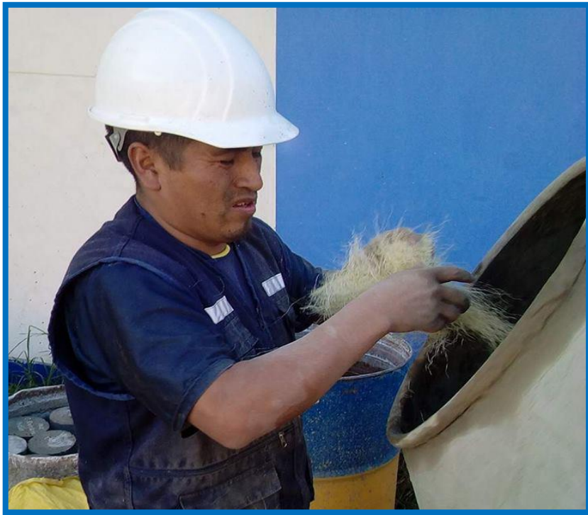
Figura 65: Adición de fibra de agave a la mezcla de concreto
