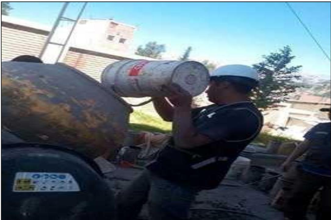
**Fotografía N°15:** *Elaboración de concreto en mezcladora mecánica.*
