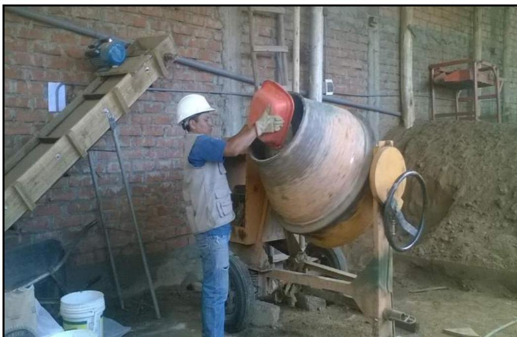
FOTO N° 4 Mezclado con el apoyo de mezcladora de concreto
