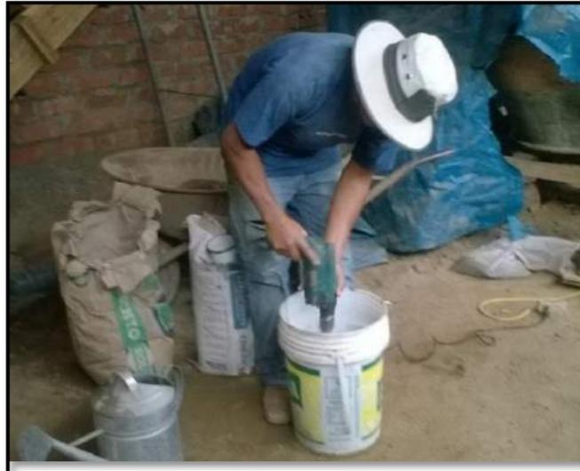
Figura II-10 Elaboración del mortero especial
