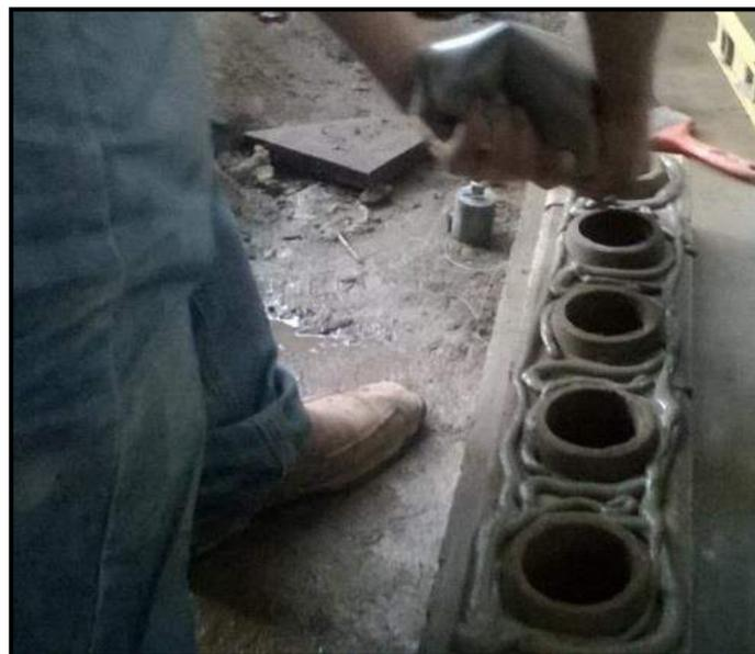
Figura II-11 Asentado de la primera hilera en muretes
