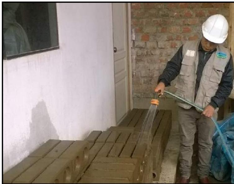
Figura II-7 Curado de ladrillos
