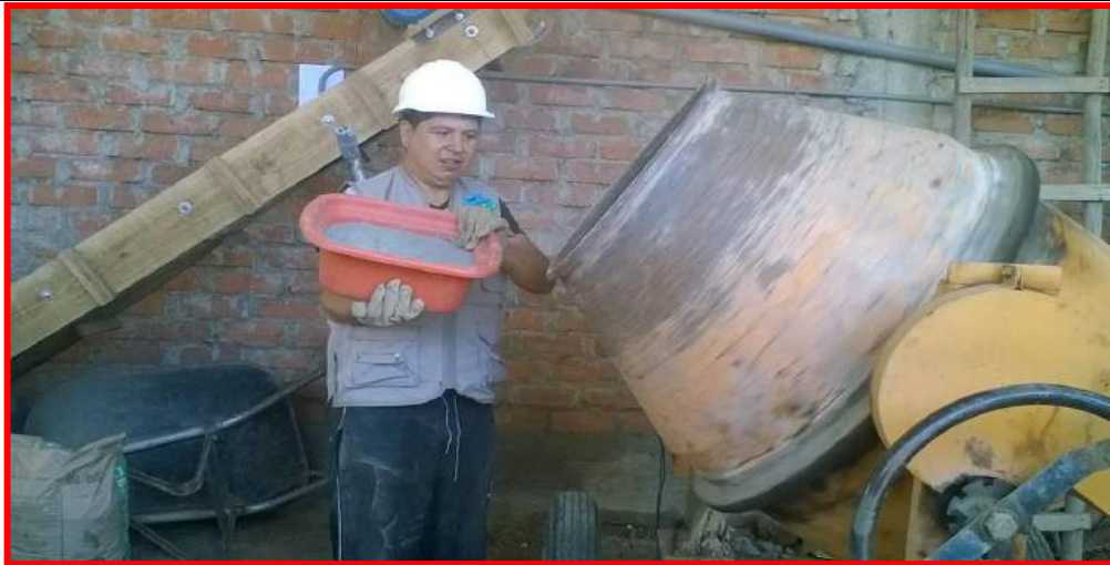
En la foto 03. Se observa el mezclado de la mezcla con el equipo mecánico
