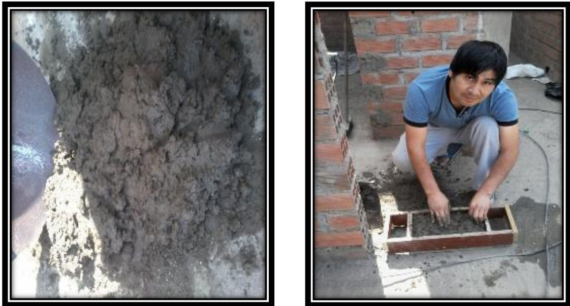
Foto. 09. Proceso de moldeo del adobe estabilizado
