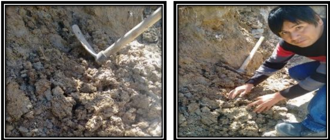
Foto. 05. Mezclado y reposo del barro
