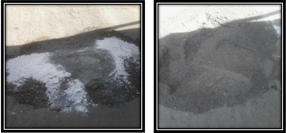
Foto. 08. Dosificación y mezclado de materiales (tierra, cal y cemento)
