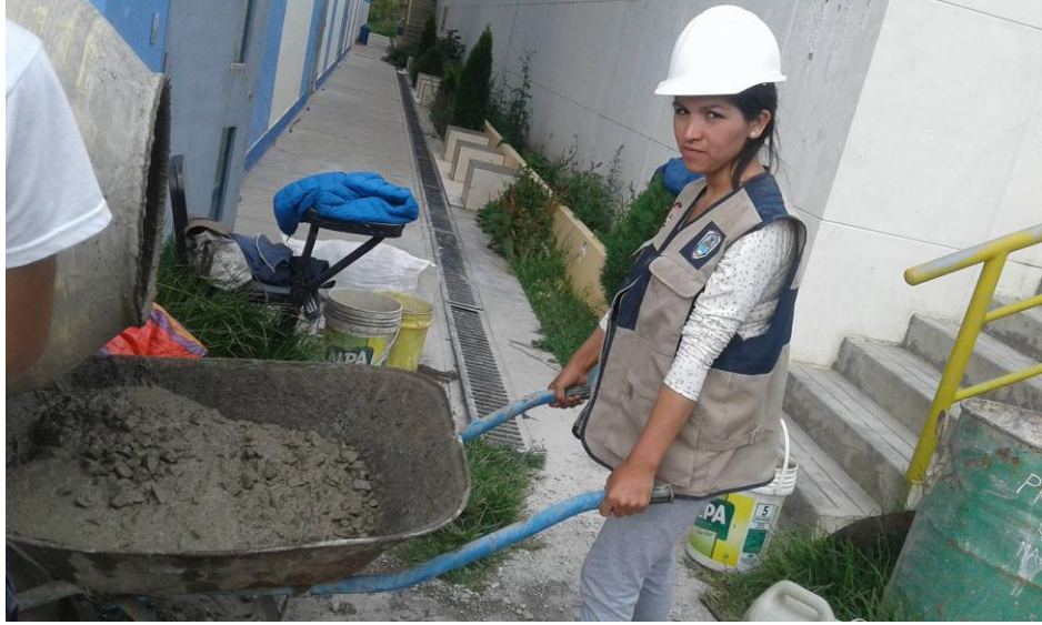
FOTOGRAFÍA 03: Realizando la mezcla
