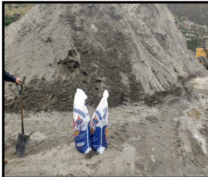
Foto 4: Agregados llenados en los sacos.
