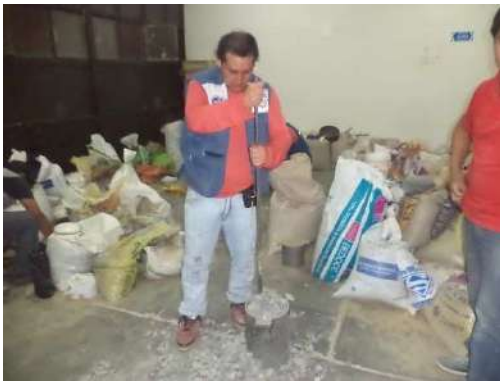
Fotografía N° 28: Compactado del agregado grueso
