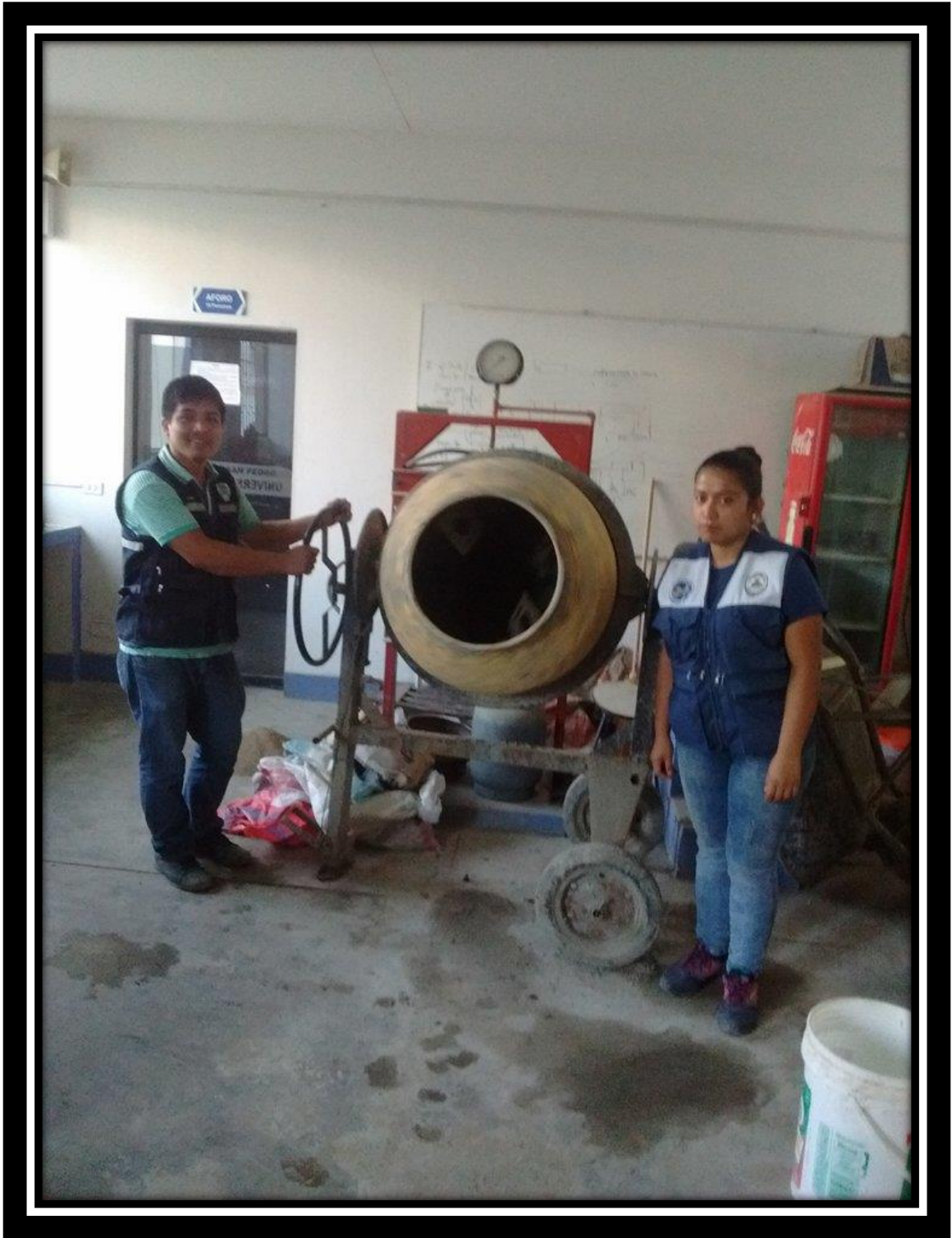
Figura N°5: Listos para realizar el concreto
