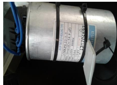
Foto 8.- Banco de capacitores trifásico para corregir el f.p.
