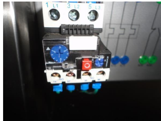
Foto 6.- Relé térmico ajustable
