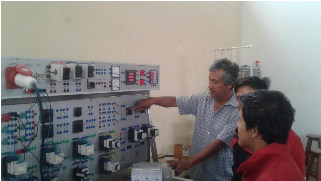
Foto 24.- Comprobando el mejoramiento del factor de potencia en una carga inductiva
