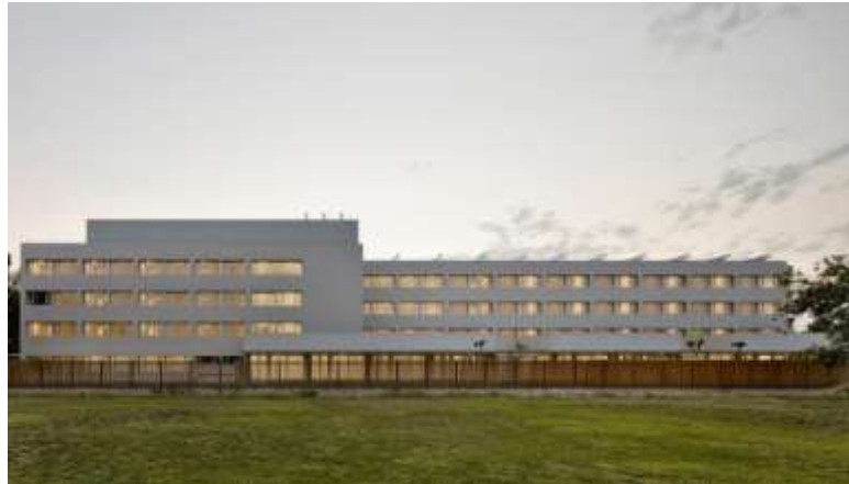
Gráfico N° 02: Vista de la Fachada de la Residencia Asistida de la Tercera Edad - Basilio Tobías, Utebo.
