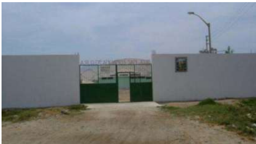
Gráfico 09: Fachada de Asilo San José. Fuente: Propia
