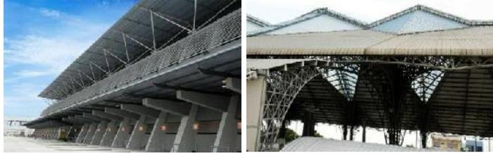
Estructuras metálicas y cubiertas de chapa que cubren la actual edificación, protegen el área de andenes de segundo piso, contribuyen a su redefinición formal y aportan al mantenimiento futuro del edificio.
