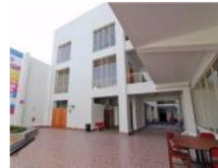
Vista de las vigas peraltadas en corredor de bloque posterior
