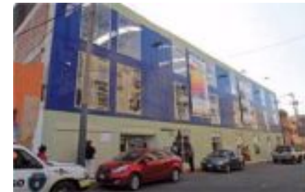
Vista del volumen principal y la fachada desde la Av. Guillermo Dansey
