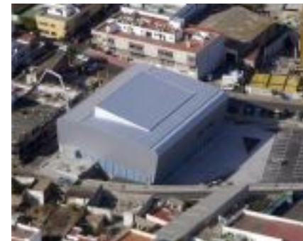
Vista aérea del conjunto del polideportivo la higuera
