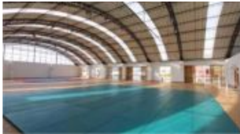
Vista de la cobertura metálica de la cancha de uso múltiple 2
