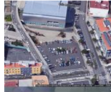
Vista aérea donde se muestra las vías colindantes al edificio
