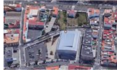
Vista del edificio y su entorno con respecto a la escasa vegetación colindante
