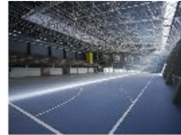
Vista del interior del edificio hacia la cancha multifuncional
