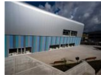
Vista del volumen principal y la fachada desde la calle prolongación José Antonio
