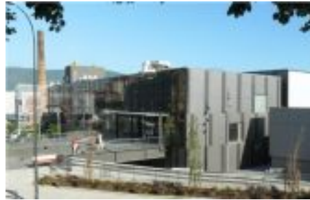
Vista del ingreso principal desde la calle Juan Thalamas Labandibar
