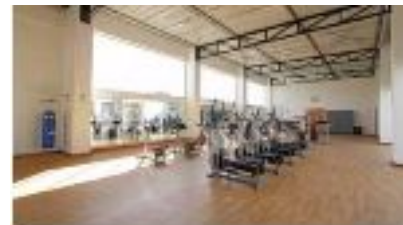
Vista de las estructuras en la cobertura del área del gimnasio
