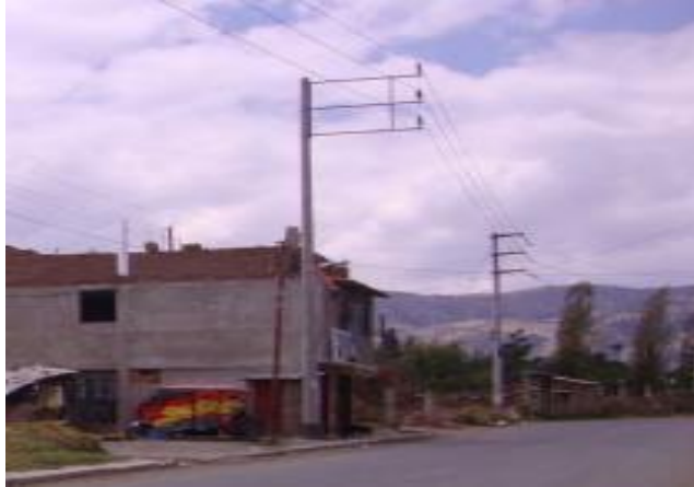
Fig. 19 Vista de servicio eléctrico del entorno
