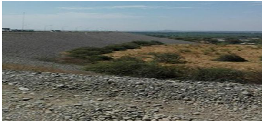
Fig. 114. MUROS DE LA REPRESA DE POECHOS
