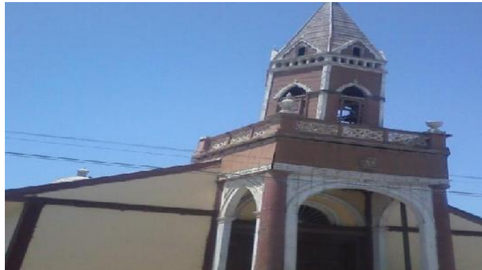
Fig. 10. CAMPANARIO DE LA IGLESIA DE LA MERCED
