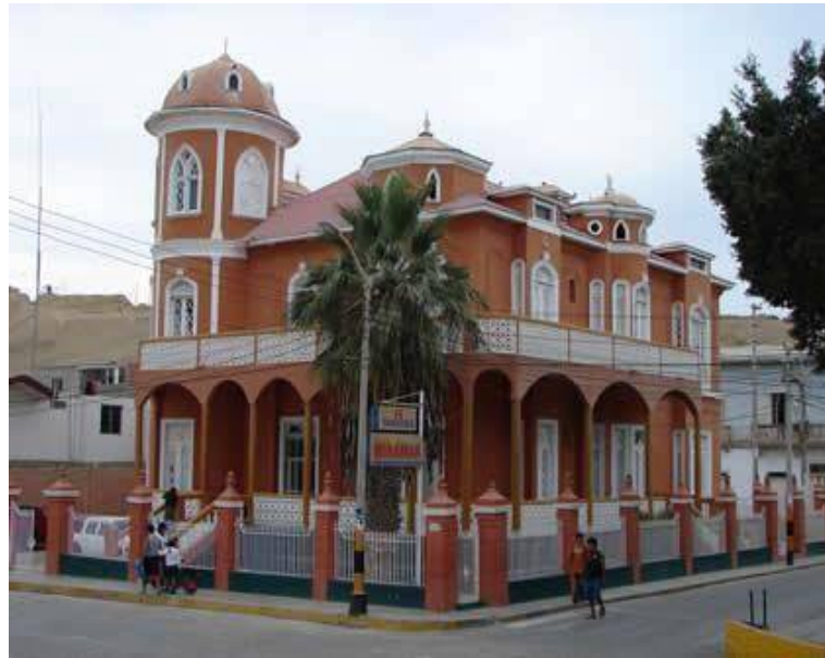
Fig. 16. LA CASA RAYGADA
