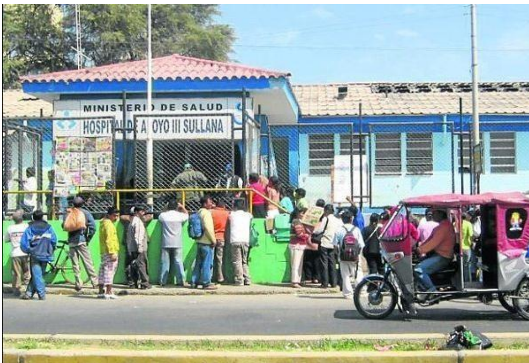
FOTO N° 01: Entrada principal de Hospital de apoyo Sullana - II
