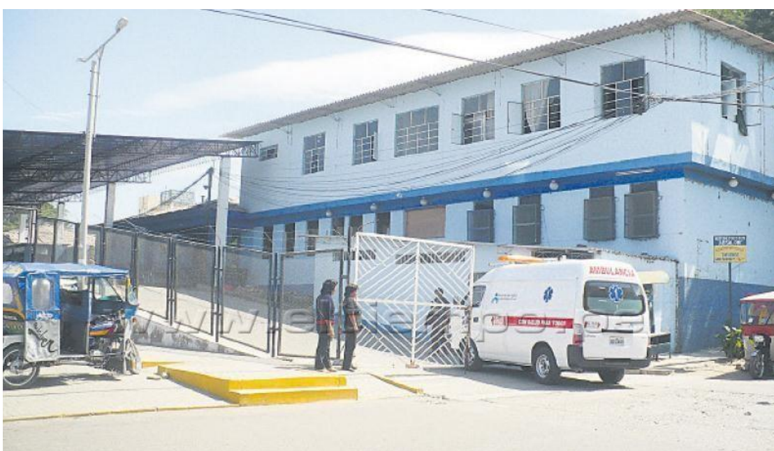
FOTO N° 02: Emergencia del Hospital de Apoyo Sullana - II
