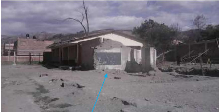
Muro de adobe deteriorado, falta sistema de evacuación de aguas de lluvia.
