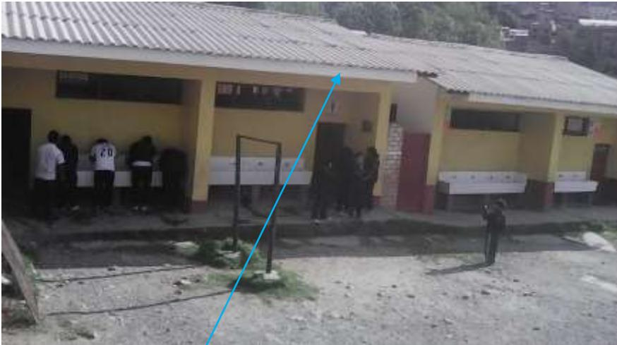
Se observa falta de canaleta y/o sistemas de evacuación de aguas de lluvia.
