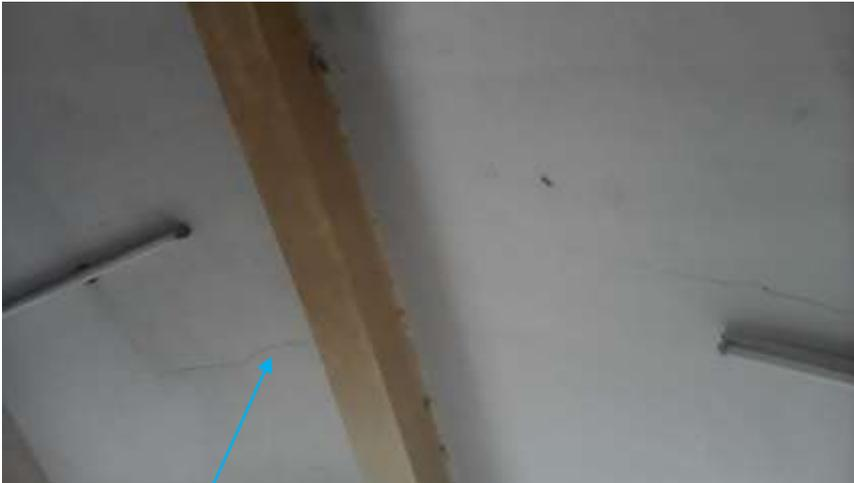
Se observa fisuras en techo aligerado.
