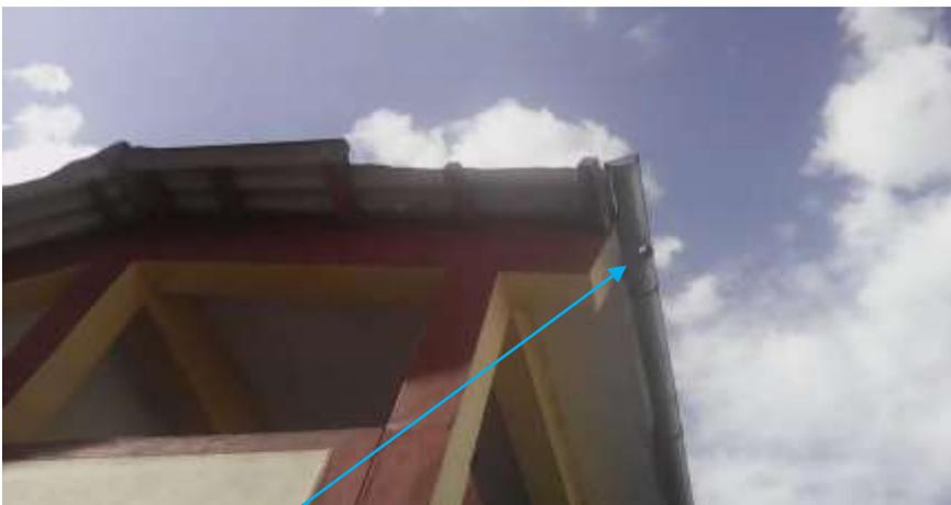
Se observa canaleta, pero falta sistema de evacuación del agua.
