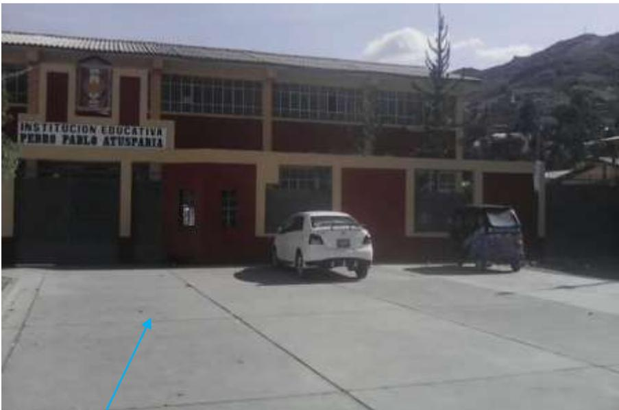
Patio de salida no tiene sistema de evacuación de aguas de lluvia.
