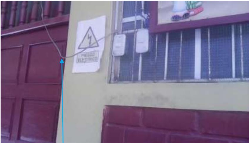
Cables expuestos, estique de señalización deteriorada.
