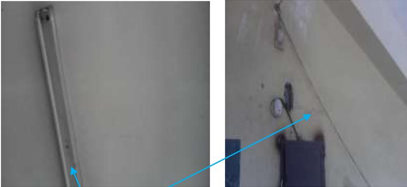
Sistema de alumbrado expuesto, falta fijar con cintillos de seguridad.
