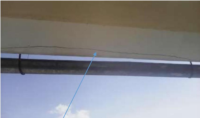
Se observa fisuras en el cielo raso.
