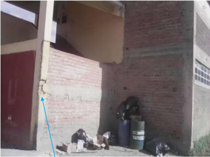
Columnas deterioradas y con fisuras.
