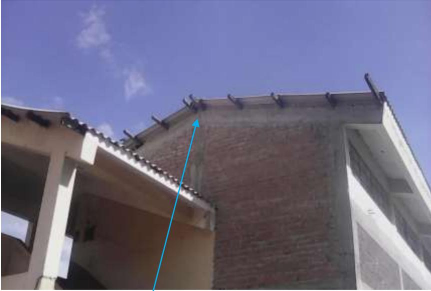
Madera deteriorada, expuesto a la humedad.
