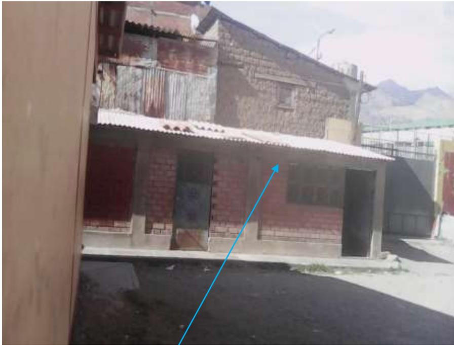
Se observa falta de canaletas y sistema de evacuación de aguas de lluvia y vivienda colindante de adobe de dos pisos.
