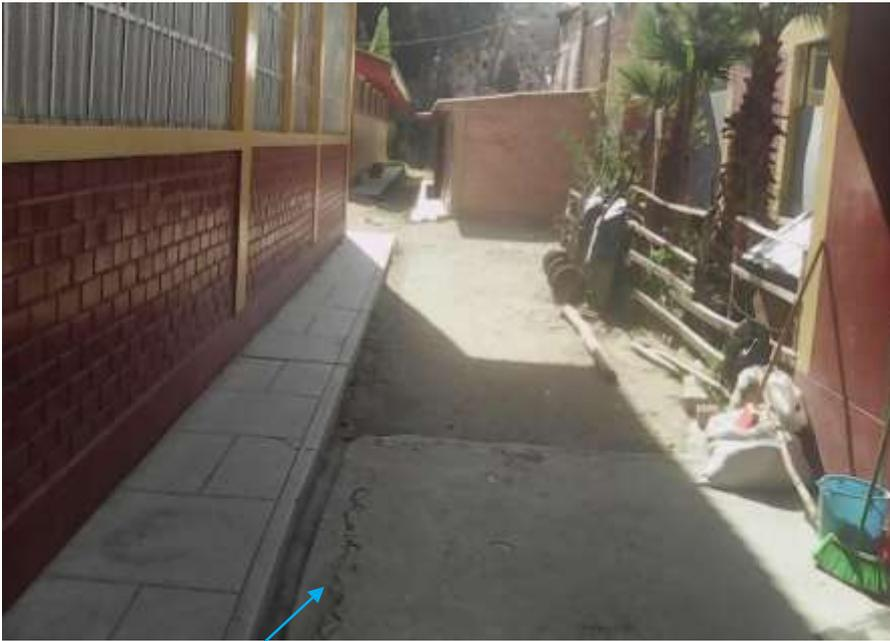
Falta sistema de evacuación de aguas de lluvia, pisos deteriorados.
