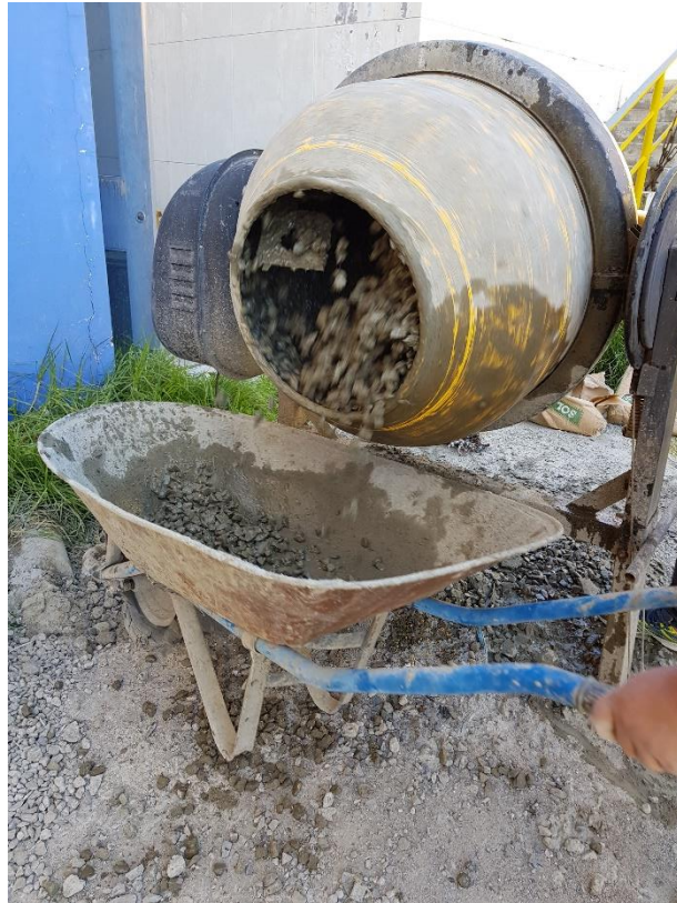
Realizando la mezcla del concreto permeable.
