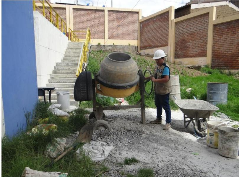
**FOTO N° 10:** Preparación de mezcla de concreto en el trompito.
