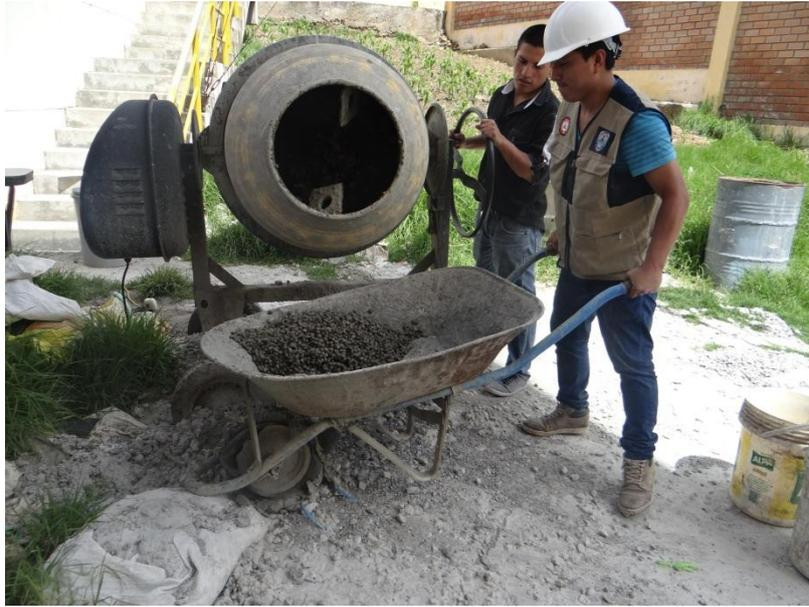
**FOTO N° 11:** Vaciado de concreto para la realización de las probetas.
