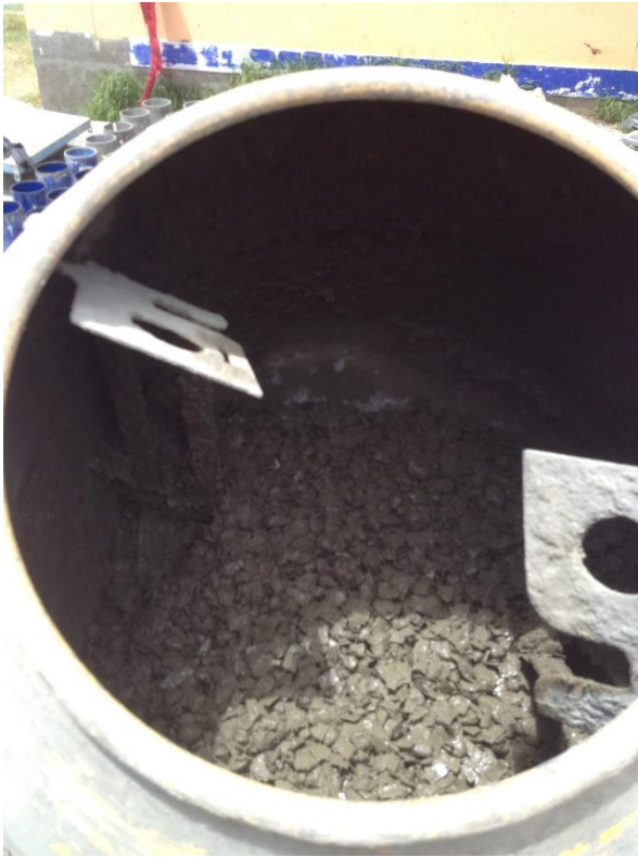
Foto N o 09: Preparación del concreto.
